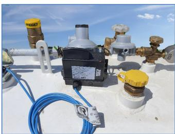
Das TEK 822 hat eine ATEX-Zulassung und über die installierte SIM-Karte sendet das Gerät die Daten an die Secu-Tech "Tank Monitoring", welche von den Wärmeversorgungsbetrieben und/oder den entsprechenden Spediteuren genutzt wird.
